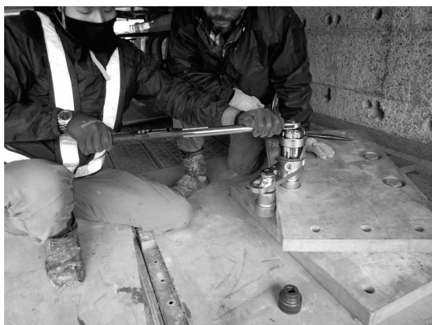
図-3 強力パワーレンチ使用状況
