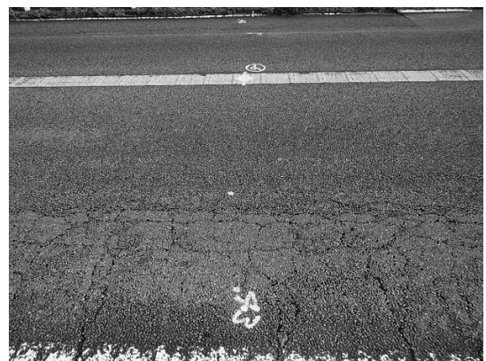
図-2 現道のクラック状況
