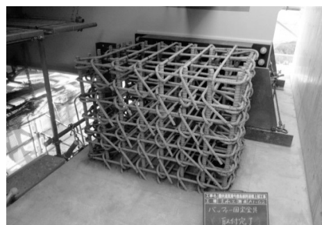
図-5 固定治具設置写真
