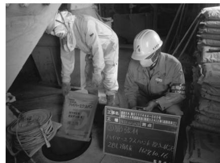
図-2 膨張材投入状況
