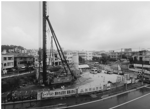
図-1 深礎混合処理工法施工時 (三点式改良機、単軸高圧噴射方式)
