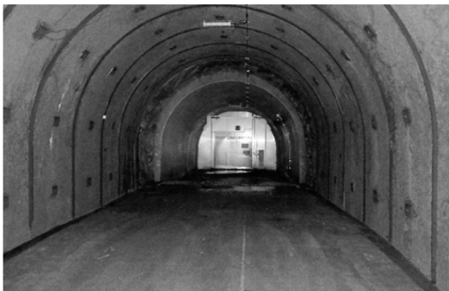
図-1 大万木トンネル内連絡坑ポンプ施設着手前写真
