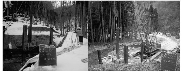
図-5 ロッド鉛直確認及び立坑削孔状況
