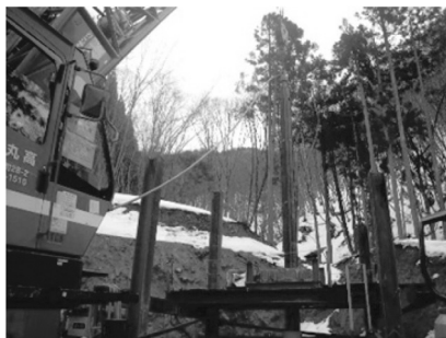
図-3 ダウンザホールハンマ テーブルマシン
