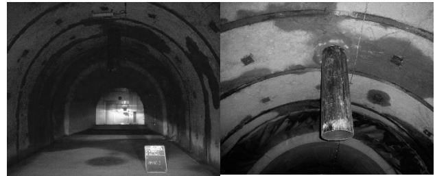
図-6 大万木トンネル内連絡坑削孔完了写真
