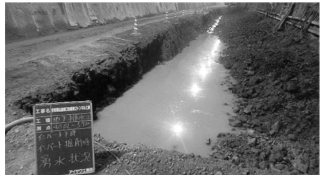
図-2 インバート床付時の湧水
