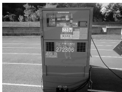
図-2 45KVA ビックタンク発電機
