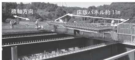
図-2 床版架設状況
