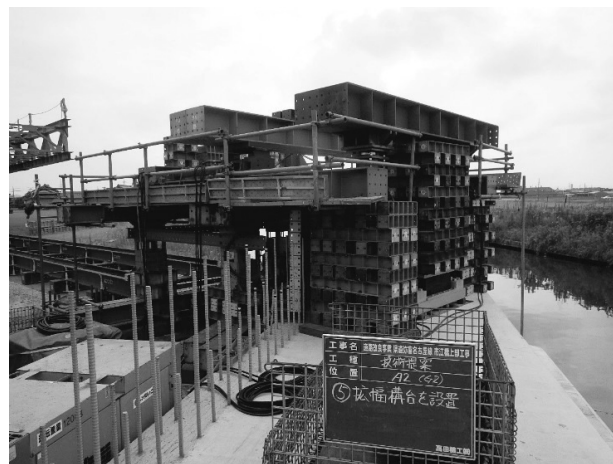
図-4 橋台上の作業構台
