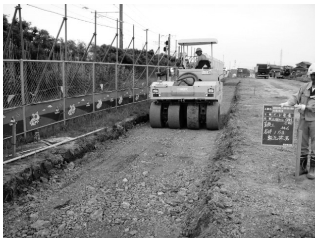
図-3 置換工法による地盤改良
