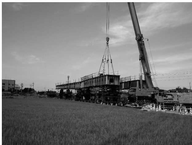
図-2 主桁組立状況
