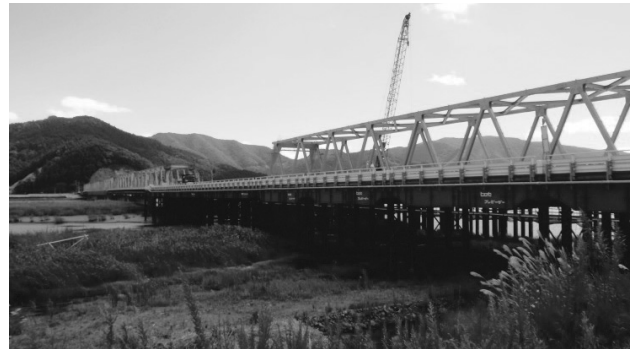
図-1 施工前状況
