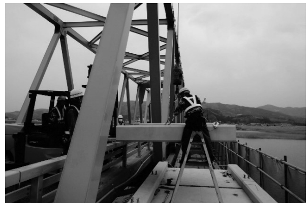
図-4 床版据付状況
