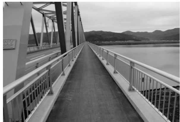
図-5 施工完了全景
