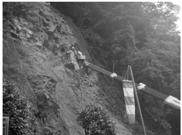
図-1 素吹き状況
