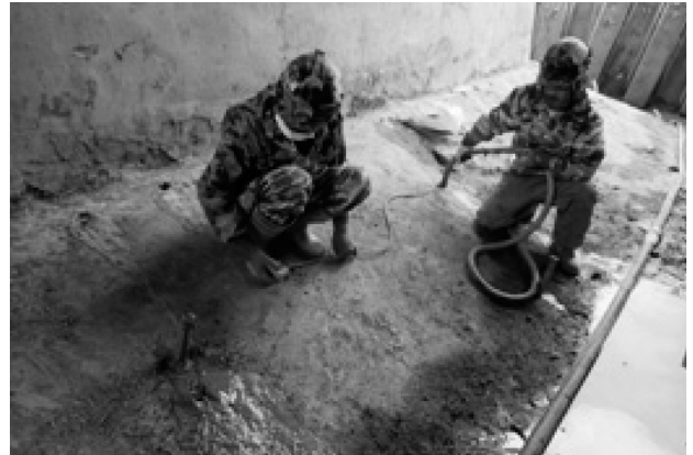
図-2 補修材注入状況
