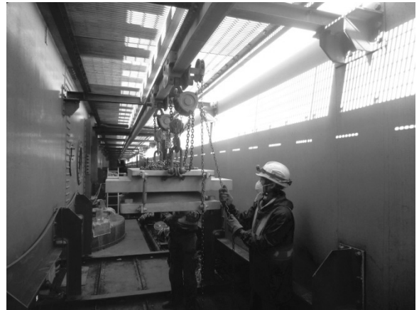
図-3 新設支承運搬状況
