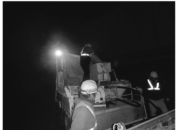
図-4 沓座モルタル打設状況
