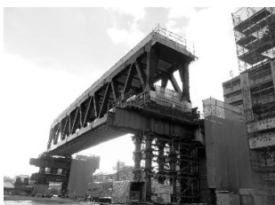
図-2 横取り架設前
