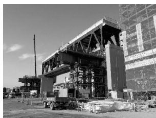
図-3 横取り架設後
