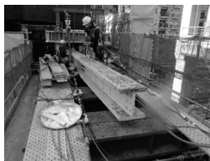
図-5 軌条設備撤去
