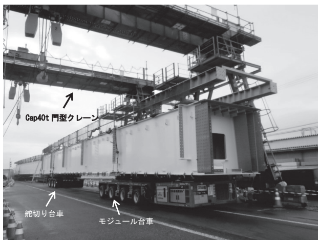
図-2 地組桁積込み状況（モジュール台車）
