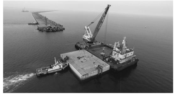
図-3 1函目ケーソン据付状況
