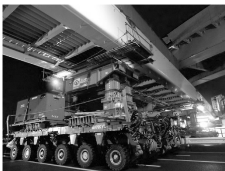
図-4 桁積載状況
