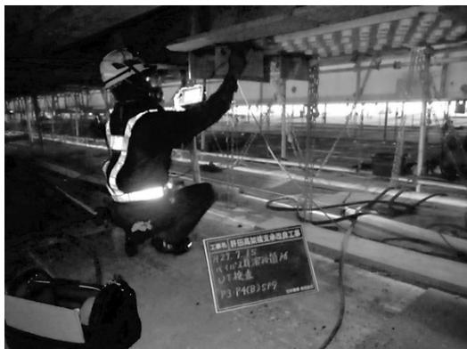
図-3 超音波探傷試験実施
