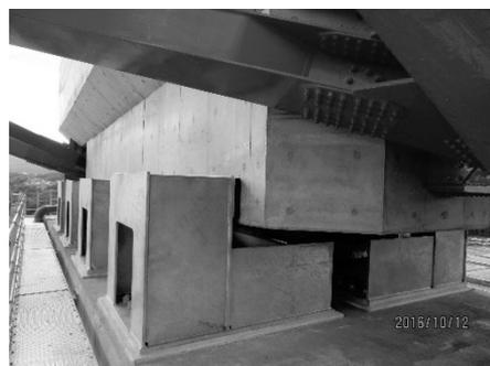
図-12 変位制限装置完成
