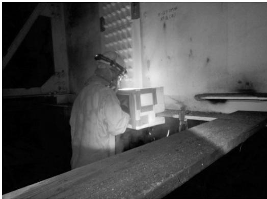
図-12 バイパス材跡補修溶射状況
