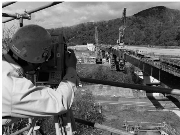
図-3 自動追尾型 TS による計測
