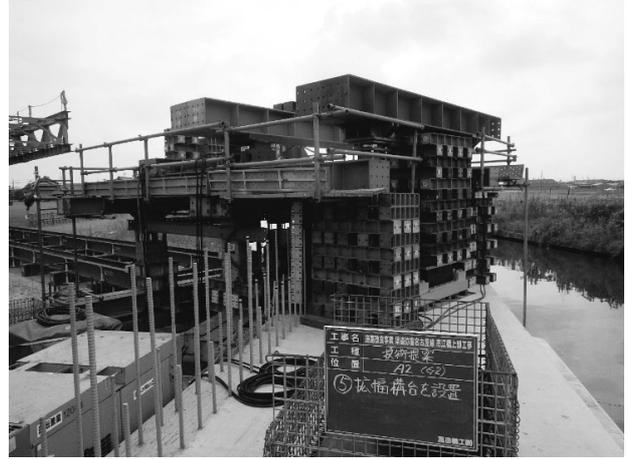
図-4 橋台上の作業構台
