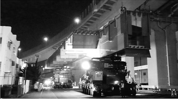
図-9 多軸台車による桁運搬（地組ヤード）
