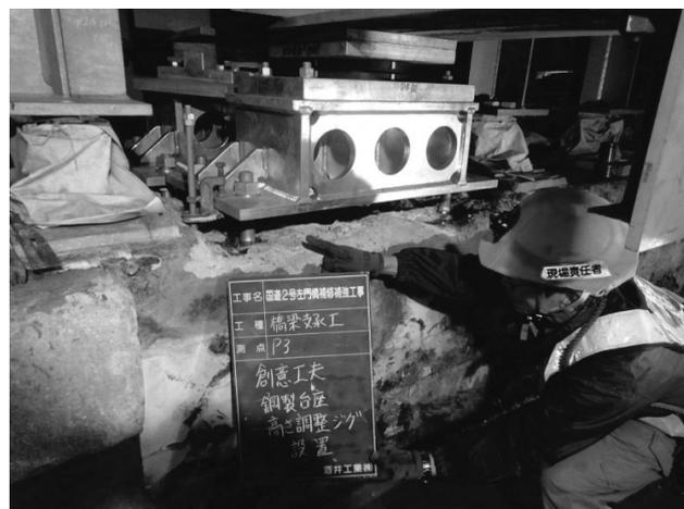
図-4 鋼製支承台座仮固定状況
