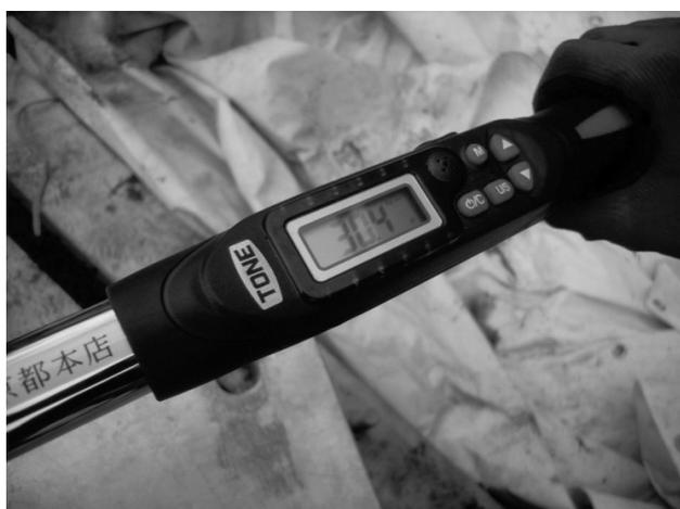
図-4 締付けトルク確認状況
