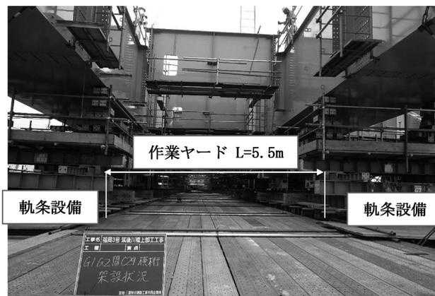
図-12 主桁間作業ヤード足場
