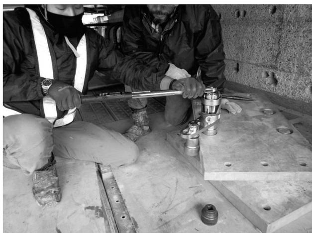
図-3 強力パワーレンチ使用状況
