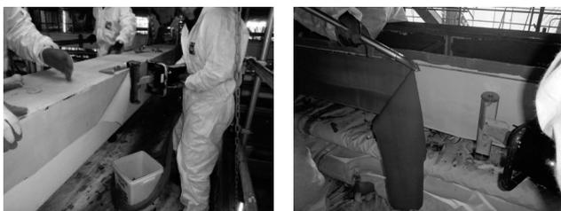
図-3 電磁誘導加熱工法
