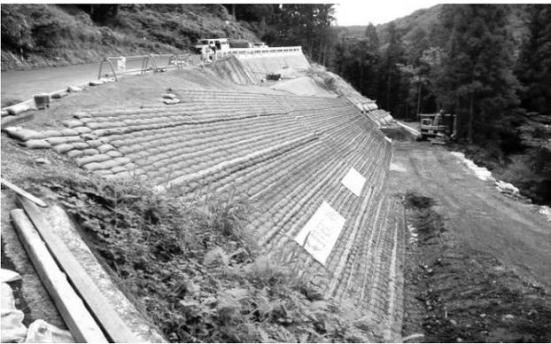
図-10 補強盛土工完了
