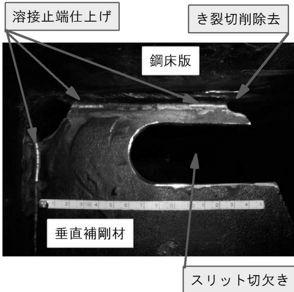
図-10 補修完了写真
