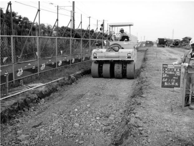
図-3 置換工法による地盤改良
