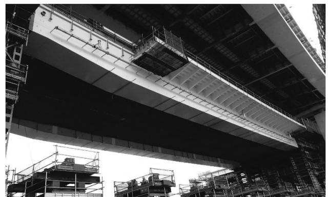
図-5 P8～P7間一括吊上げ架設完了
