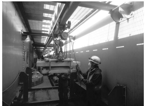
図-3 新設支承運搬状況
