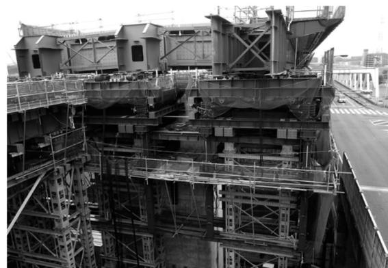
図-8 高速降下装置機構と設置状況
