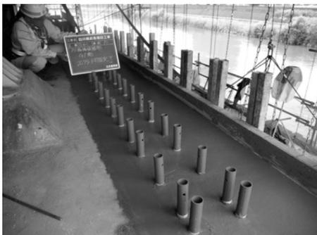
図-4 新規縁端拡幅部アンカーボルト用箱抜きパイプ (削孔から変更)
