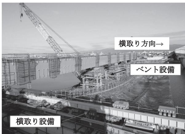
図-3 鋼桁横取り状況
