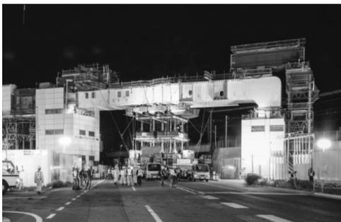
図-3 多軸式特殊台車による一括架設状況
