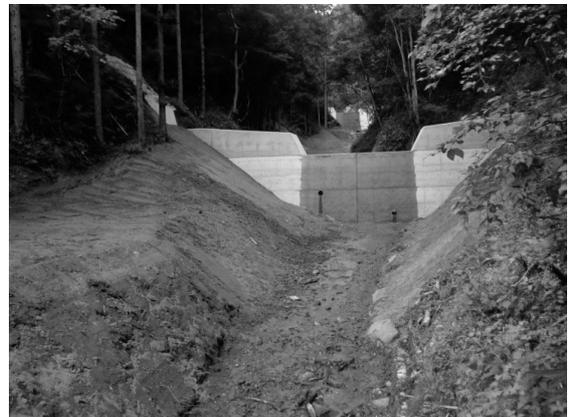
図-1 完成写真(手前-床固工・奥-谷止工)
