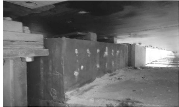
図-2 箱桁の桁下部削孔完了
