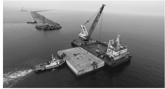
図-3 1函目ケーソン据付状況
