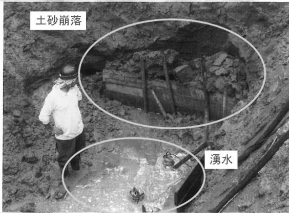
図-2 湧水状況（隣接工事施工時）
