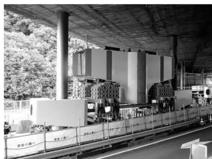
図-7 鋼製梁横取り・縦取り完了
