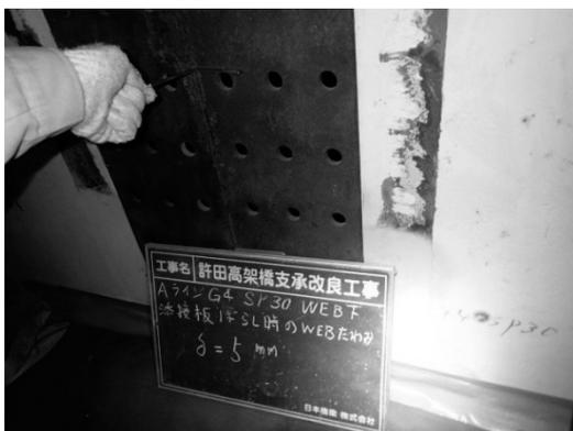
図-7 連結板取り外し時のたわみ量
