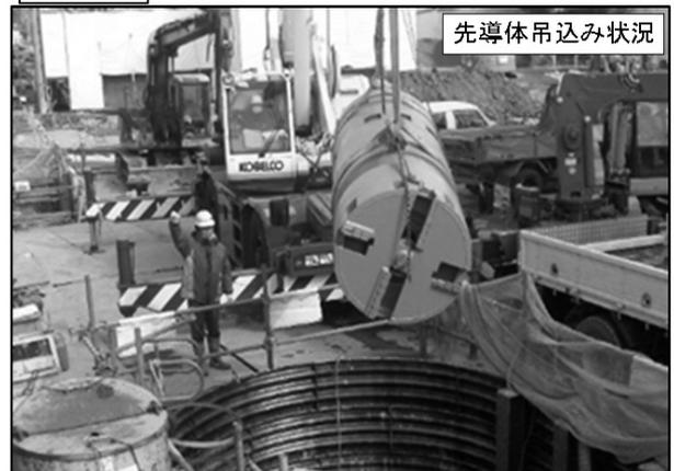
図-4 推進工施工状況
