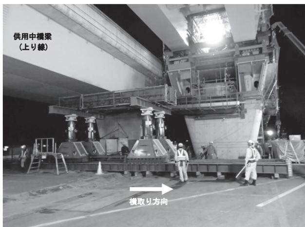
図-5 後方側降下装置横取り状況写真
