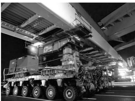
図-4 桁積載状況
