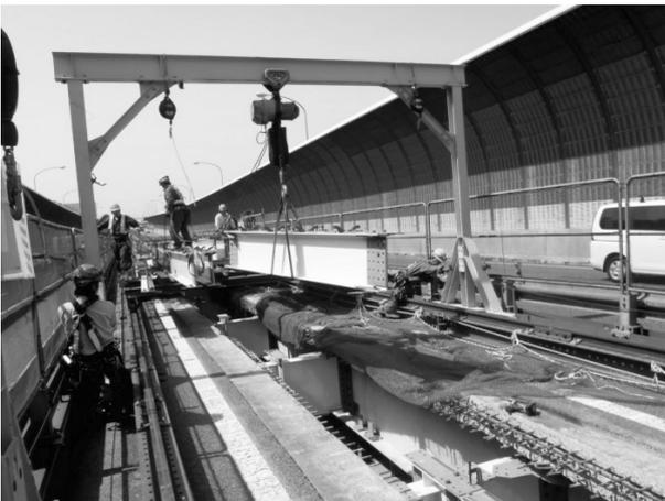
図-7 縦桁架設状況
