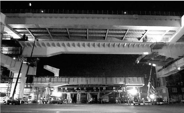
図-10 多軸台車よりの吊上げ架設（主桁単体）
