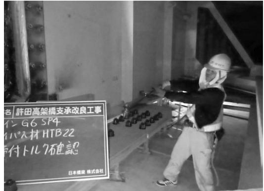
図-4 バイパス材連結板トルク確認
