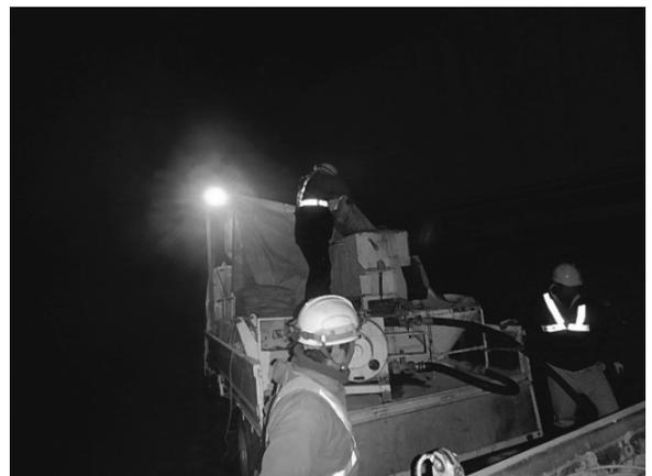
図-4 沓座モルタル打設状況
