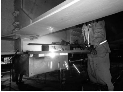
図-10 レール装着による切断
