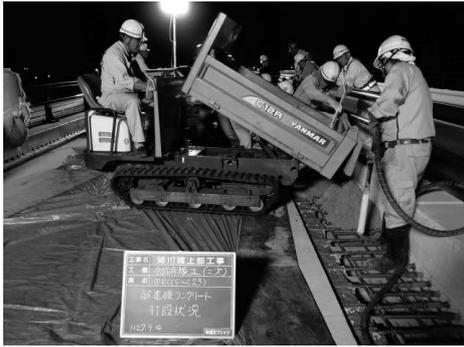
図-9 二次床版コンクリート打設状況
