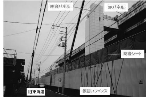
図-5 防音・飛散防止状況
