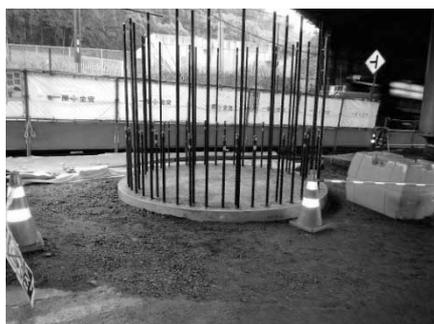
図-5 RC柱1次施工完了
