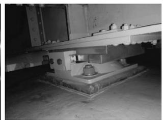
図-8 ステンレス板取付状況 図-9 補修後の支承
