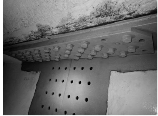
図-8 ボルト抜け落ち写真
