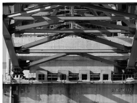
図-13 変位制限装置全景
