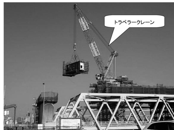
図-5 トラベラークレーン架設状況
