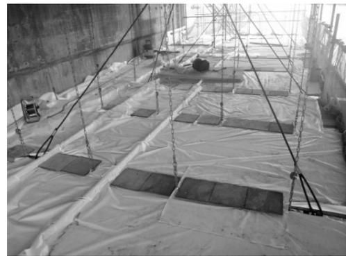
図-6 足場の吊上げ構造
