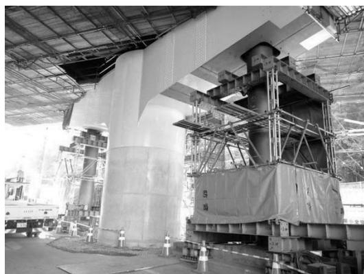
図-12 ロッキングピア撤去設備
