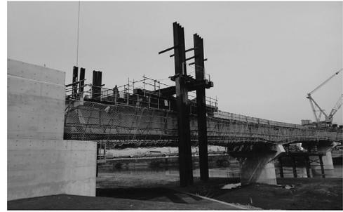
図-3 H鋼杭の運搬状況
