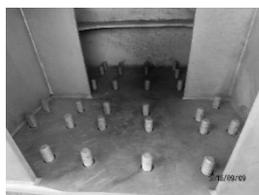
図-11 アンカーボルト配置
