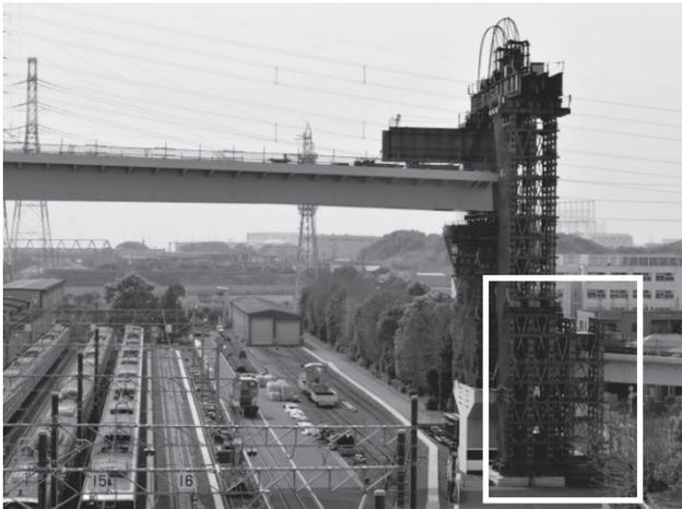
図-7 低層部を拡幅（□枠内）した門構
