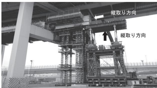
図-2 主桁リフトアップおよび縦取り（G1桁）
