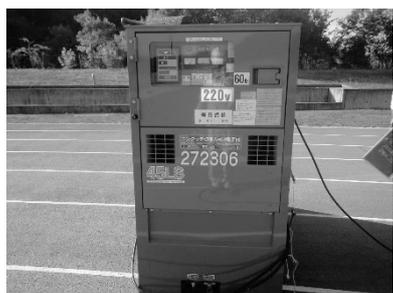
図-2 45KVA ビックタンク発電機
