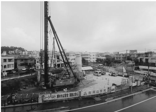
図-1 深礎混合処理工法施工時
