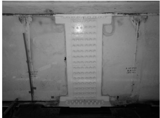
図-14 連結板取替完了
