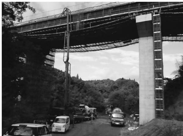
図-4 床版コンクリート打設状況
