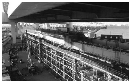
図-5 後方桁連結状況
