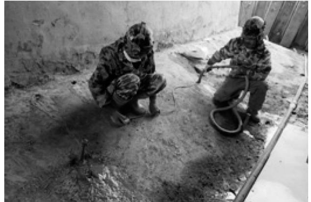
図-2 補修材注入状況
