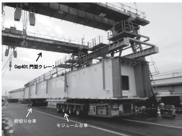
図-2 地組桁積み込み状況（モジュール台車）
