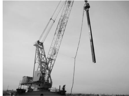
図-4 キャプタイヤケーブル取り回し状況
