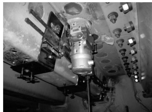
図-8 自動機械切断機の設置状況
