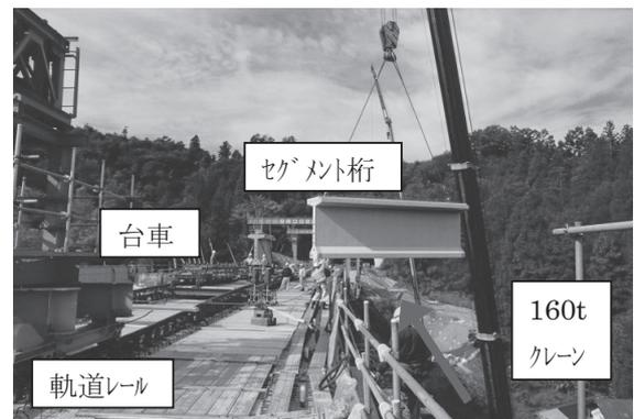
図-6 セグメント桁吊り上げ状況
