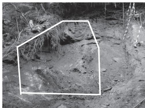
図-9 崩落岩盤・不安定土塊除去完了
