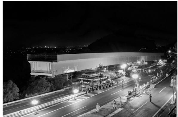
図-2 運搬架設時の状況
