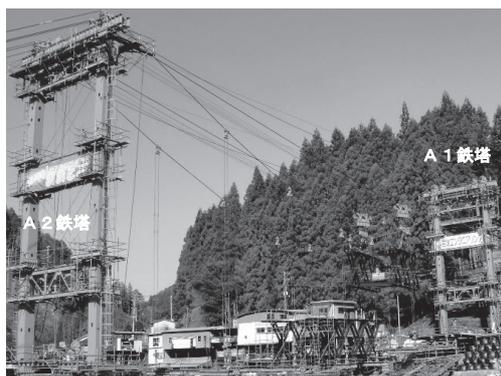
図-3 主桁架設状況
