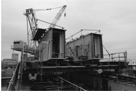
図-2 主桁の運搬状況
