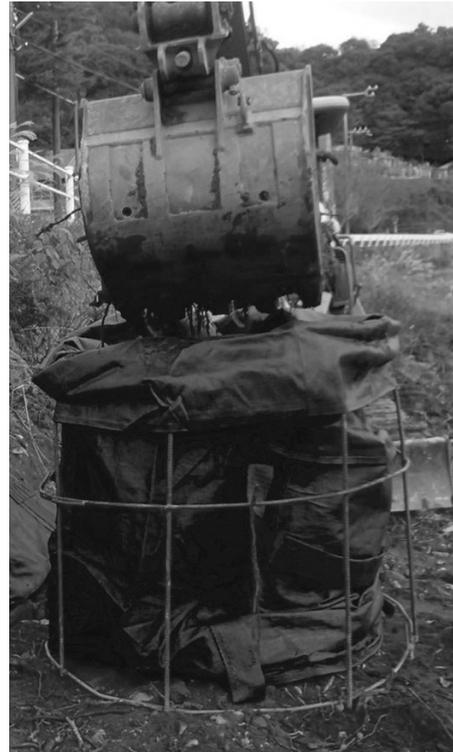
図-2 大型土嚢作製器使用状況
