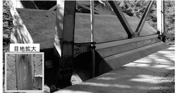
図-14 アーチ基部コンクリート施工完了
