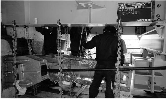
図-6 制震ダンパー設置状況
