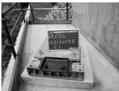
図-10 A1橋台固定装置
