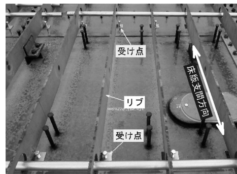
図-8 合成床版の内部鋼材
