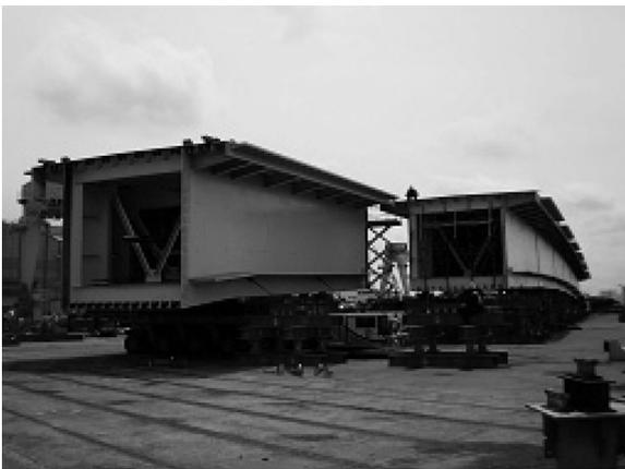
図-11 ユニットキャリアによる地組立状況
