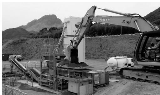
図-3 INSEM 材製造専用攪拌機 (作業状況)
