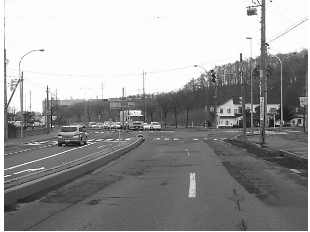
図-10 作業前L側 (2012.3)
