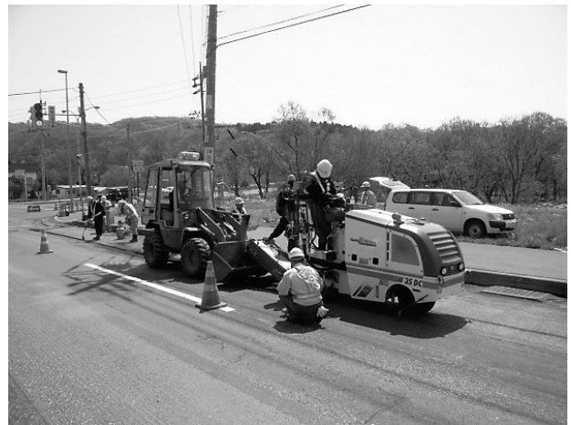
図-7 クラック部溝切削状況
