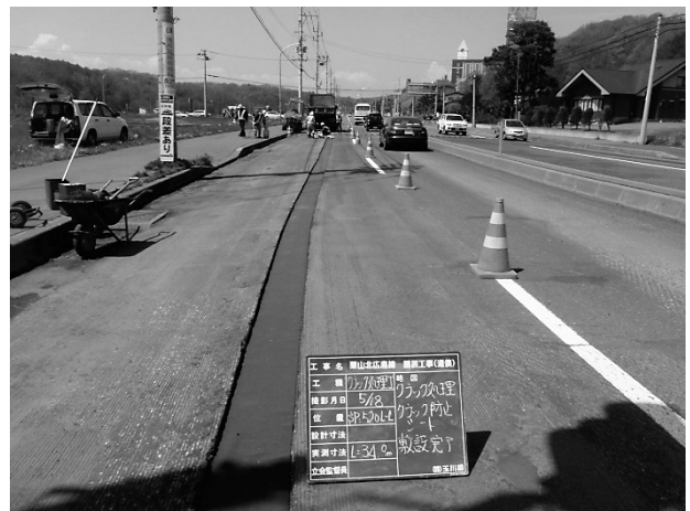
図-8 クラックシート設置状況
