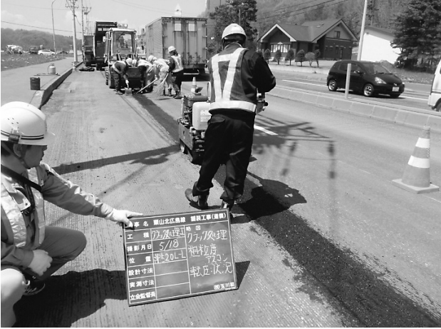
図-9 基層舗装状況
