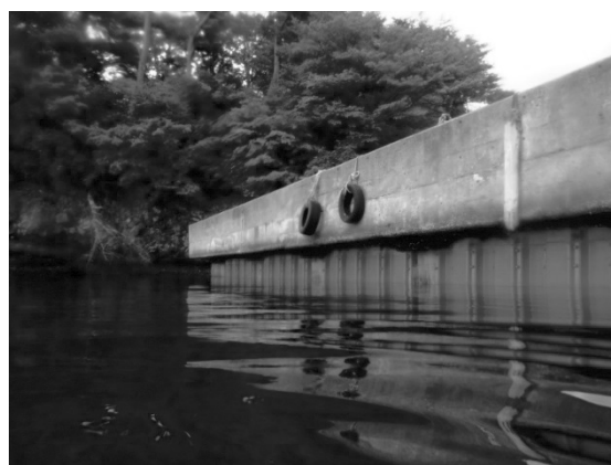
図-11 追の浜（B）防波堤被覆防食完成
