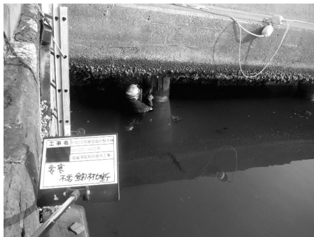
図-7 不要鋼材切断状況
