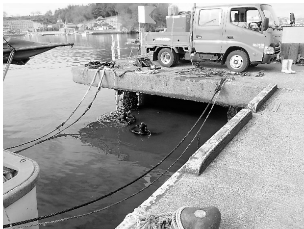
図-4 事前調査作業状況
