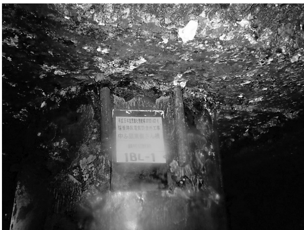
図-3 不要鋼材撤去前
