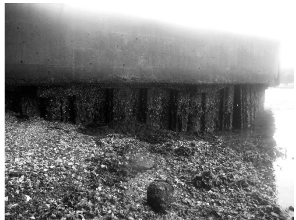
図-1 追の浜防波堤被覆防食施工前
