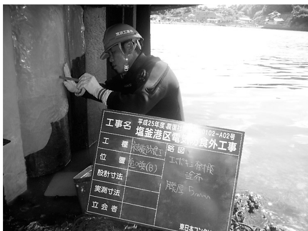
図-5 水中硬化型エポキシ樹脂施工状況
