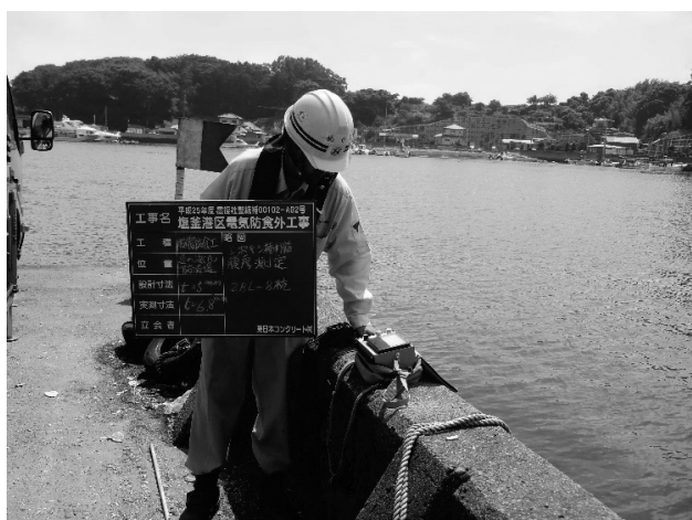
図-6 膜厚計による膜厚測定状況
