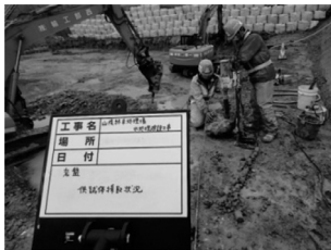
図-2 削孔状況
