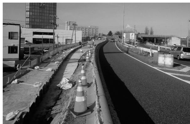
図-7 仮設ガードレール設置完了
