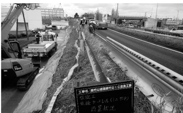
図-6 仮設ガードレール設置状況
