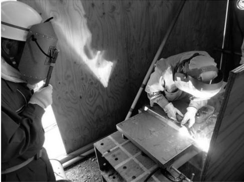
図-10 溶接技量試験実施状況
