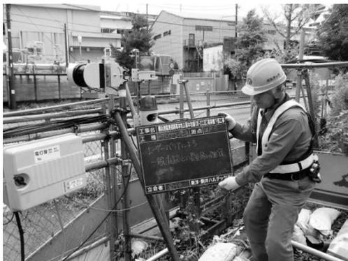
図-7 レーザーバリア設置状況
