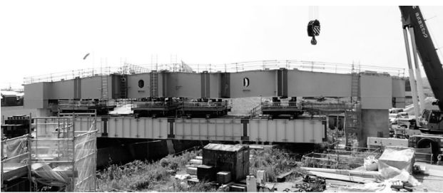
図-6 横梁架設完了
