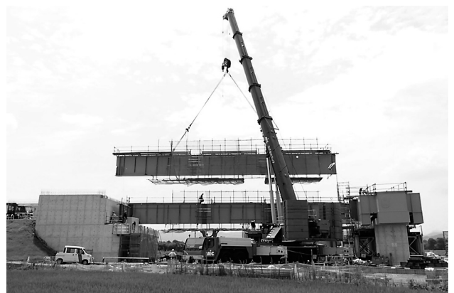
図-8 右岸側主桁架設状況
