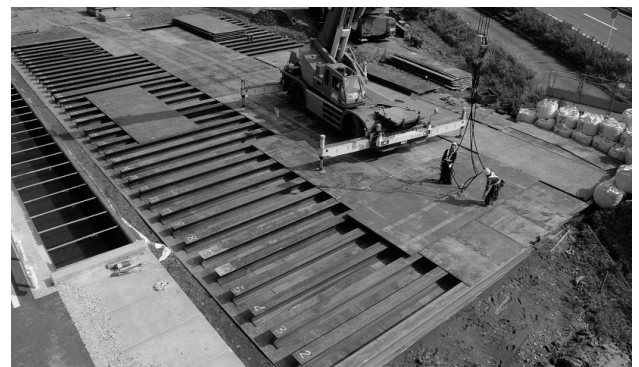
図-7 クレーン構台組立状況
