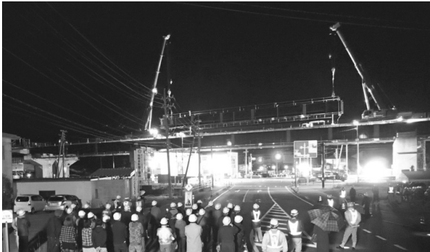
図-6 相吊り架設
