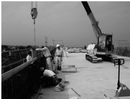
図-6 ミニクローラによる外型枠の設置
