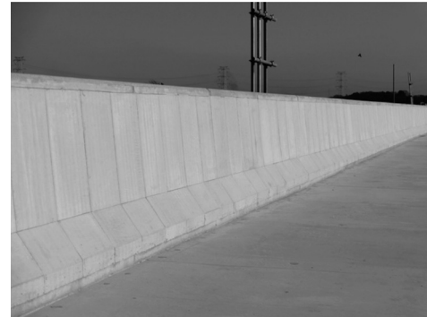
図-10 壁高欄施工完了
