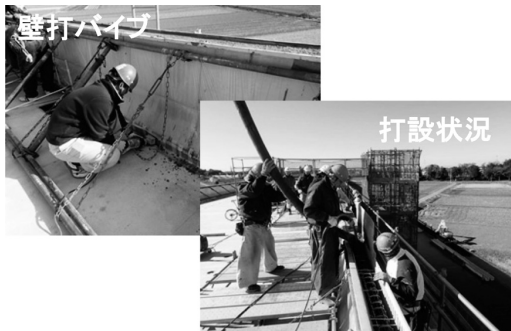
図-9 埋設型枠打設状況
