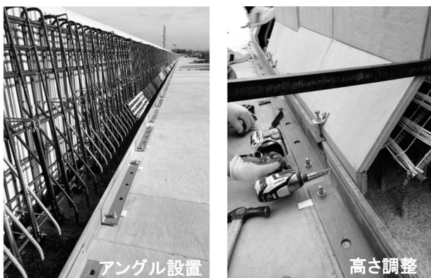
図-7 内型枠の設置
