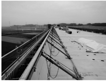
図-8 埋設型枠設置完了
