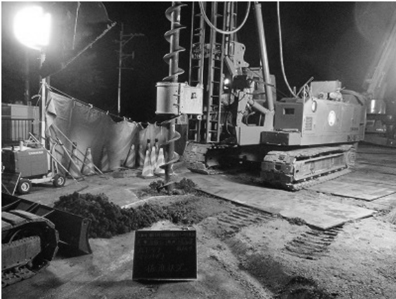
図-3 親杭打設施工状況
