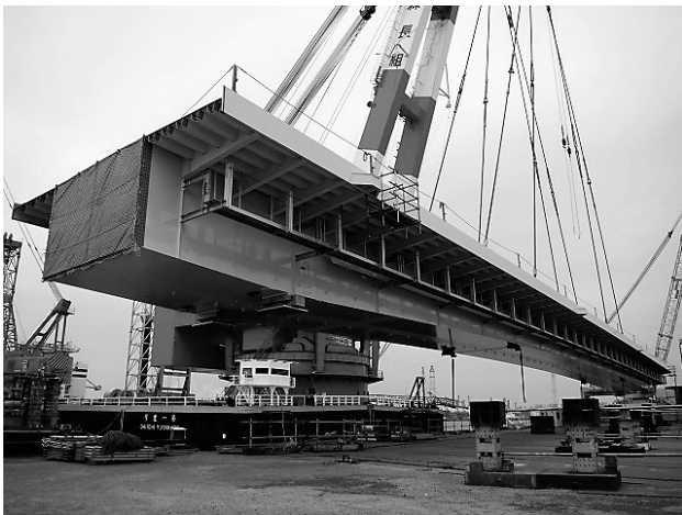
図-3 桁浜出し状況
