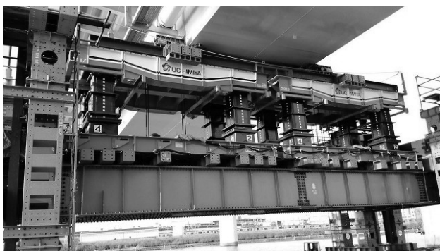
図-6 デッキリフト降上状況
