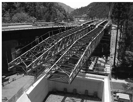
図-1 送出し架設状況
