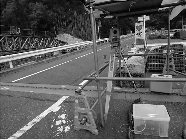
図-6 送出し桁先端位置測量状況
