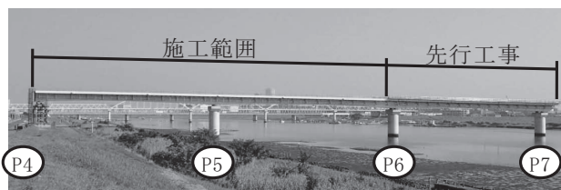
図-1 工事完了写真(施工範囲)
