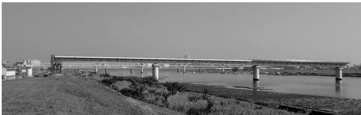
図-5 工事完成状況
