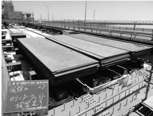
図-6 カウンターウェイト設置状況
