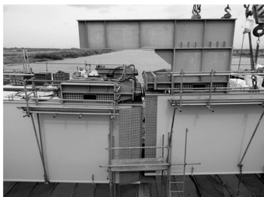
図-4 閉合前の仕口変形状況
