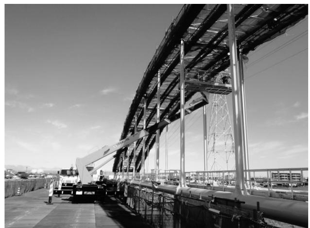
図-8 高所作業車による足場撤去
