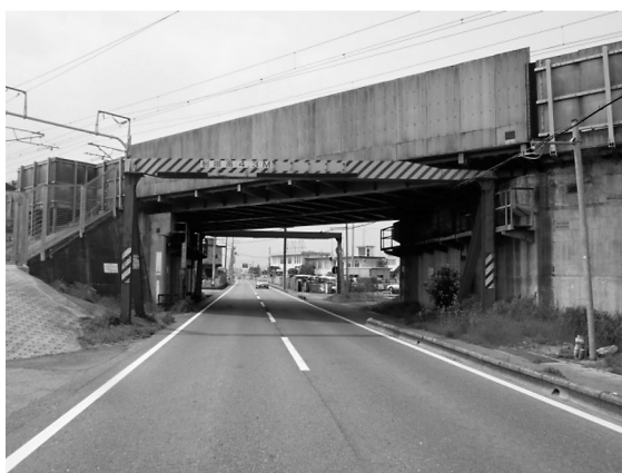
図-1 第一友定 Bv 橋梁の写真
