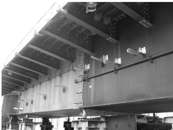
図-9 仮組立状況（右側が再利用桁）
