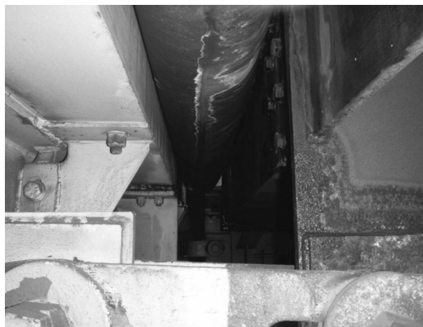
図-4 伸縮装置からの漏水と桁端の腐食状況
