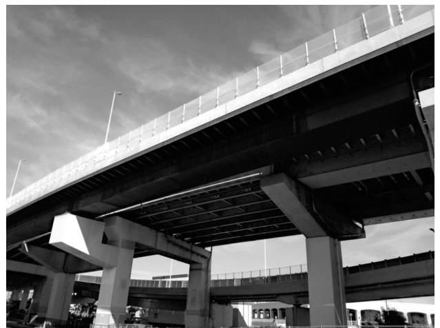
図-10 【施工後】再利用されたランプ橋
