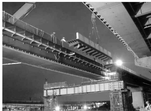
図-7 既設入路ランプ橋の解体
