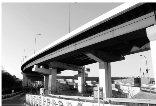
図-2 【施工前】既設入路ランプ橋
