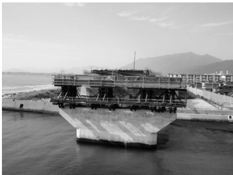
図-12 橋脚上送出し設備設置状況
