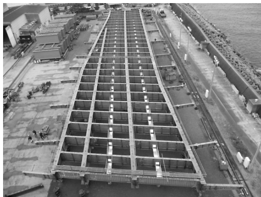
図-2 拡幅部の仮組立状況
