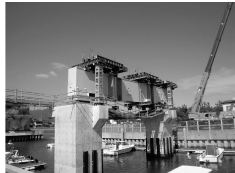
図-9 横梁を利用した基礎設置状況
