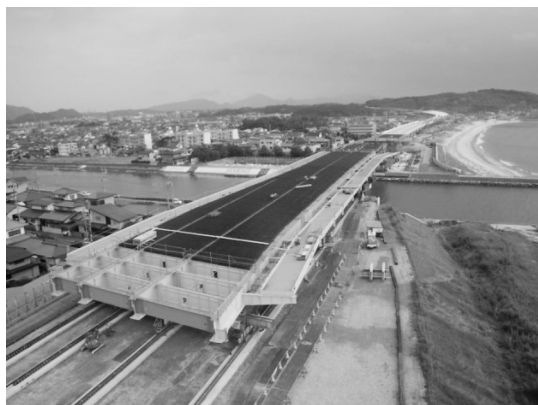
図-1 綾羅木川橋送出し状況
