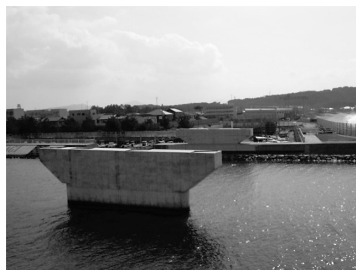
図-4 綾羅木川と渡河部の橋脚
