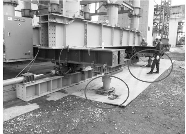
図-8 橋脚付近地盤沈下状況
