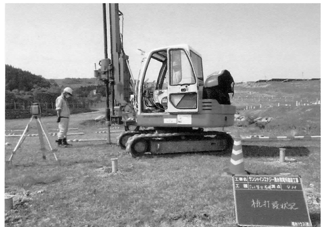
図-4 GTスパイラル杭
