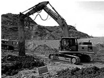
図-3 地盤改良施工状況
