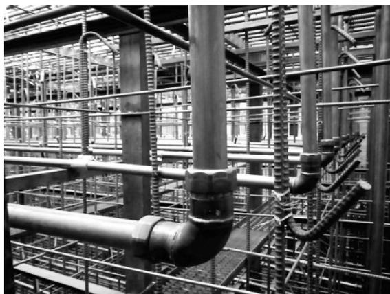
図-8 パイプクーリング配置状況
