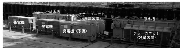
図-9 パイプクーリング循環設備
