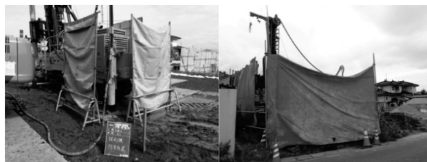
図-5 防音シート・ブルーシート囲い状況
