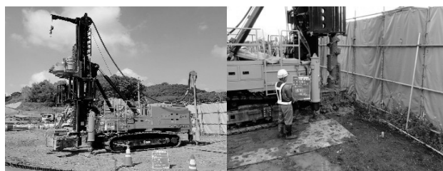
図-4 掘削機／施工状況
