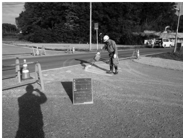
図-3 粉じん防止剤フライネット散布状況
