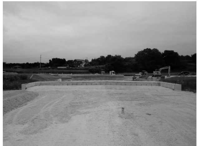
図-1 工事着手前
