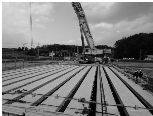
図-4 主桁架設完了（N=13本）
