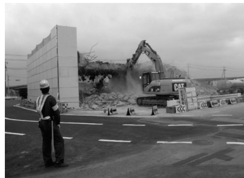
図-4 ボックスカルバート取壊し
