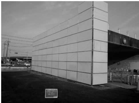
図-2 飛散養生設備（仮設足場）
