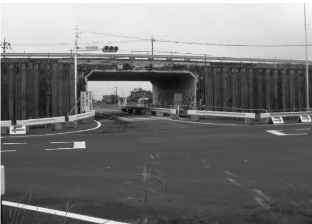
図-1 ボックスカルバート現況
