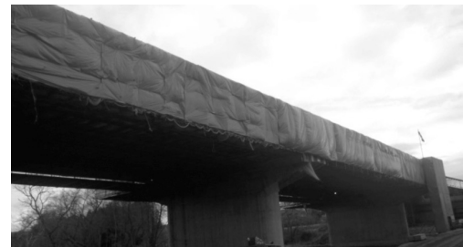
図-5 現場塗装養生状況
