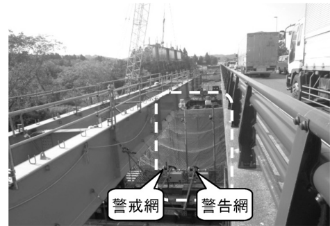
図-3 2段階吊り荷監視システム
