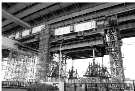
図-2 地組み桁リフトアップ状況
