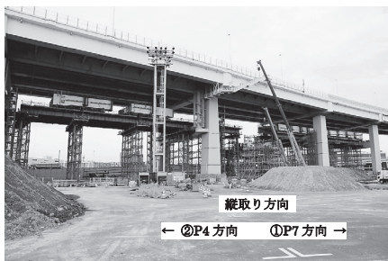
図-1 縦取り架設状況
