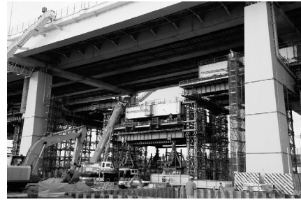
図-3 桁の荷揚げ地組み状況
